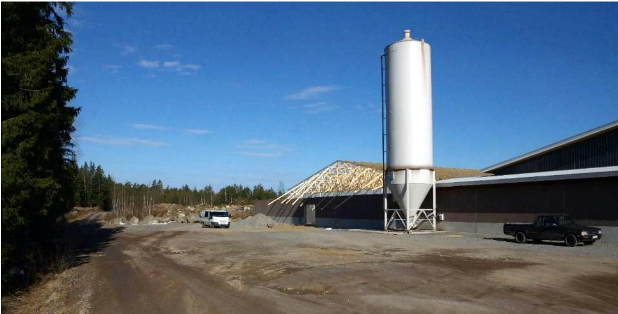
Kuva 15. Näkymä Kumolantieltä länteen. Toinen kanalarakennus on rakenteilla huhtikuussa 2026.
